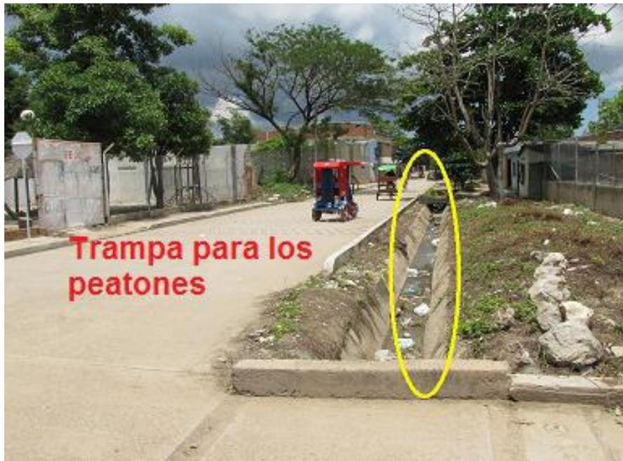
Registro fotográfico 54 Cunetas profundas sin protección- acera en mal estado – Municipio de Bosconia. Fuente: Elaboración Propia.
